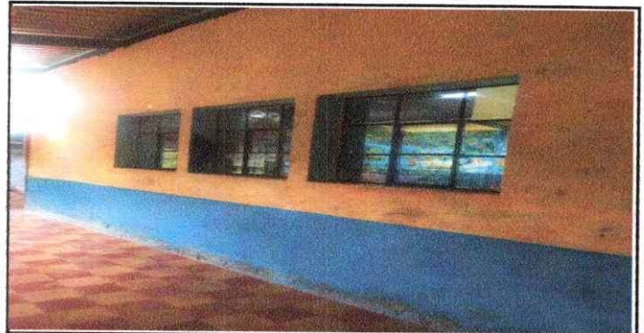
Foto 6: Se requiere aplicación de pintura de muro exterior e interior.
